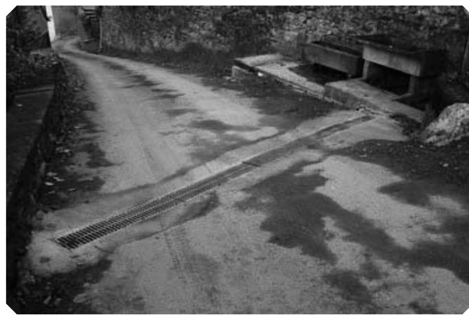
Rénovation d'un passage d'eau pluviale.
