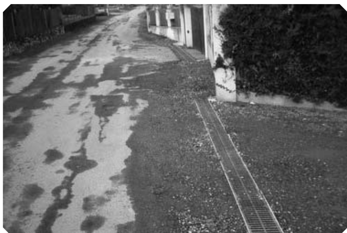
Réalisation d'un pluvial avec puisard.
